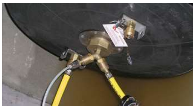
Próba szczelności z użyciem sprężonego powietrza
